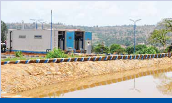
Marafiq Schlammwässerung - 4 Mobile Containeranlagen 4x 8 m 3 /h, Jubail Industrial Zone 1, KSA, Saudi Arabien
