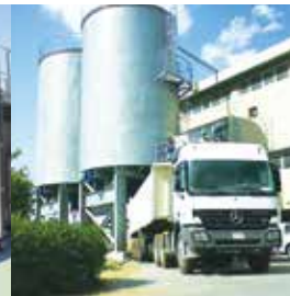
Tratamiento de lodos
