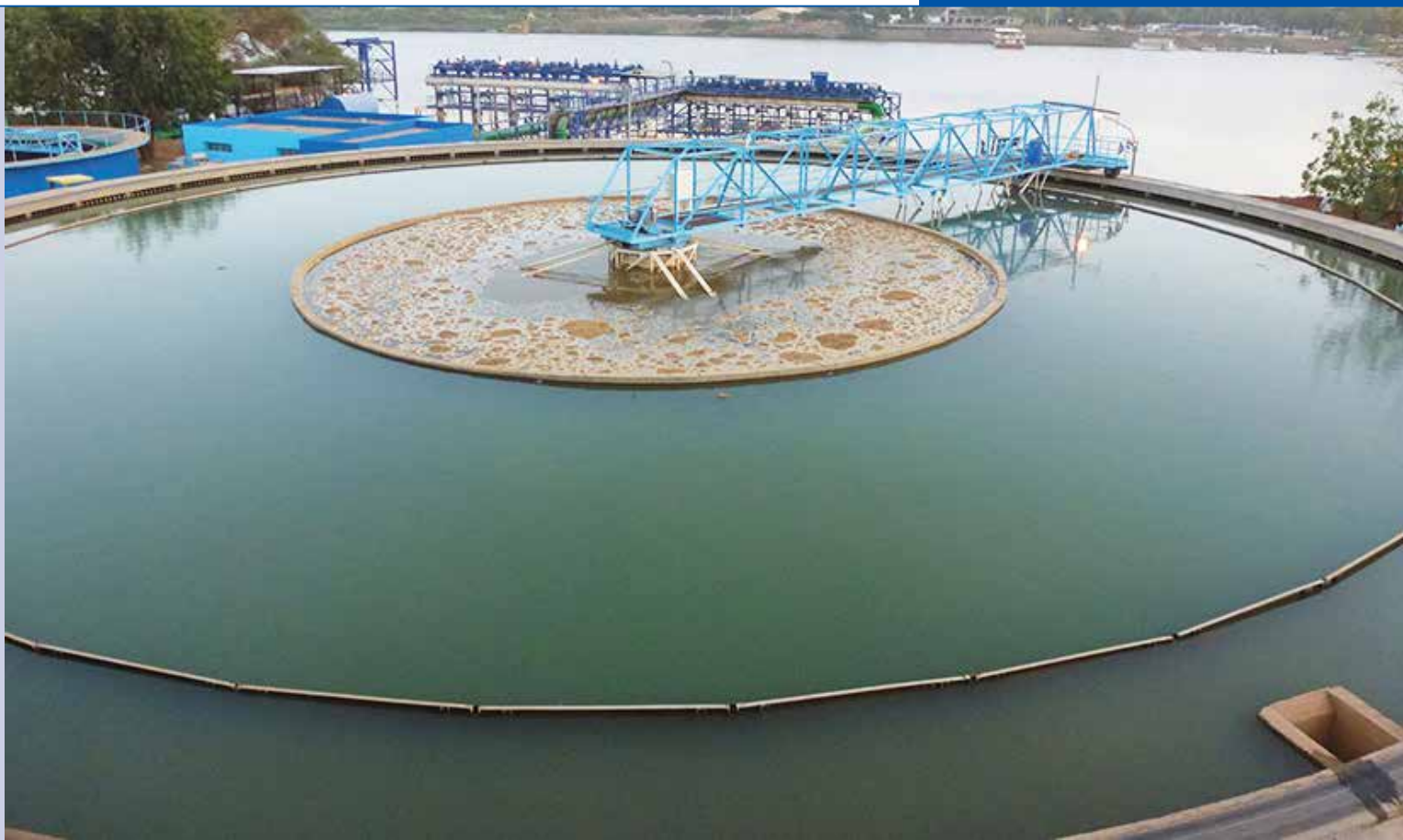
Bahry PWT – naprava za pitno vodo, sanacija in razširitev kapacitete (350.000 m 3 /d) – severni Khartoum, Republika Sudan
