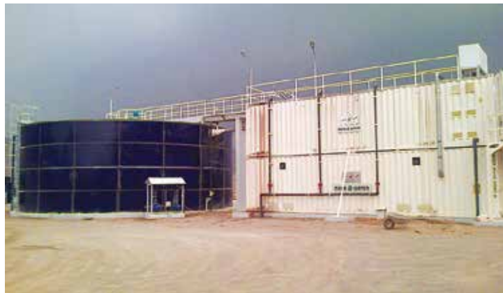
Третиране на солена вода със система за обратна осмоза, 300 m 3 /d, Москва, Русия
