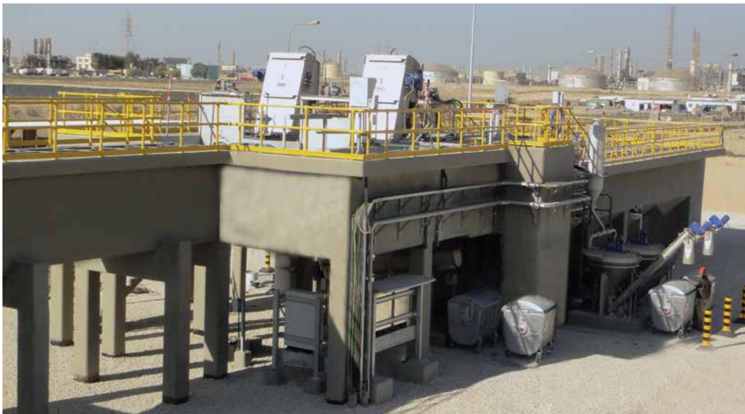
Marafiq - Промислени отпадни води. Предварително пречистване, 66000 m 3 /d - Джубаил, KSA
