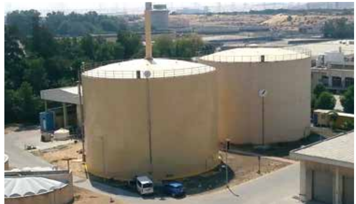
Reacondicionamiento del gasómetro de la PTAR Warsan 4000 m 3 /day, Dubai - U.A.E.
