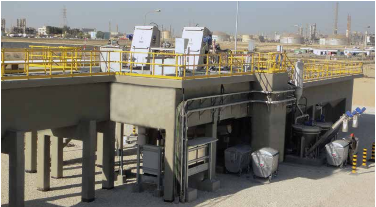
Planta de tratamiento de aguas residuales de Marafiq – Pretratamiento 66000 m 3 /day, Jubail - KSA
