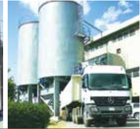
Tratamiento de lodos
