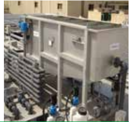
Aguas residuales industriales
