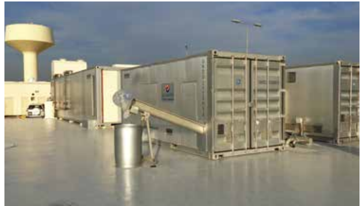
Durrat Al Bahrein MBR uređaj za čišćenje otpadne vode, 2.000 m 3 /d Bahrein
