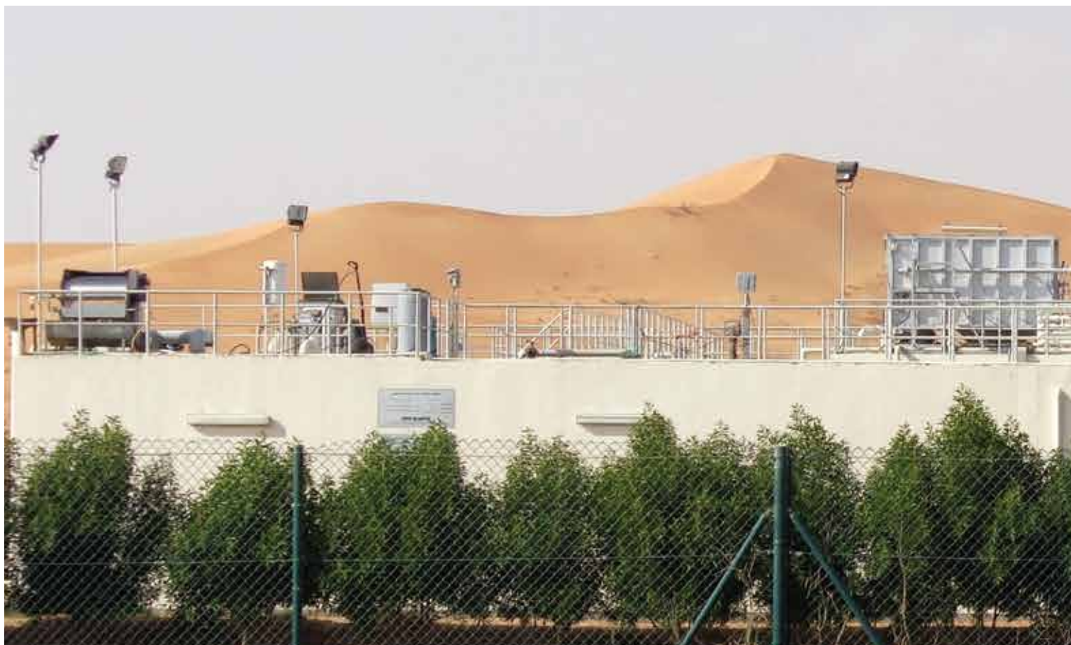
Al Ain – klaonica I obrada perutnine, uređaj za čišćenje otpadne vode, 400 m 3 /d Al Saad, Al Ain – Ujedinjeni Arapski Emirati
