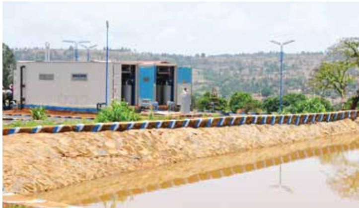
Marafiq dehidracija blata - 4 mobilna kontejnerska uređaja, 4x 8 m 3 /h, Jubail industrijska zona 1, Kraljevina Saudijska Arabija
