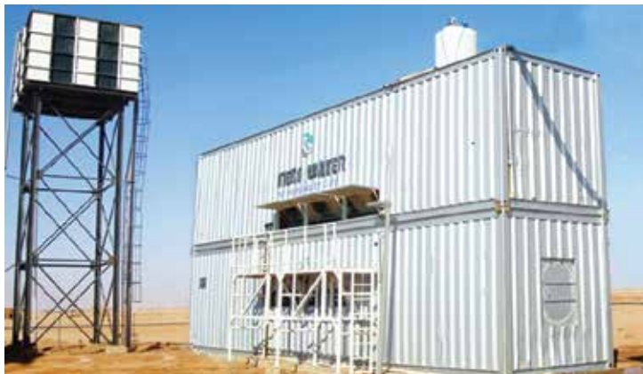
Marafiq - odwadnianie osadów - 4 mobilne urządzenia kontenerowe, 4 x 8 m 3 /dzień, Jubail Industrial Zone 1, Arabia Saudyjska
